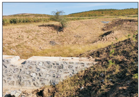
东辽县侵蚀沟治理项目区谷坊
