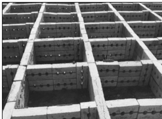
图 8 固沙砖沙障的铺设形式
