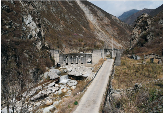
图 3 泥石流对汶川登溪沟排导槽底板的冲磨破坏(矩形槽底)
