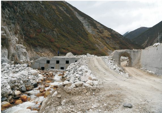
图 2 2019 年 8 月泥石流对登溪沟拦砂坝的冲磨破坏
