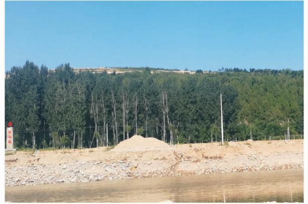
图 13 暴雨后弥河岸坡冲刷情况 (韩剑桥摄于 20190820)
