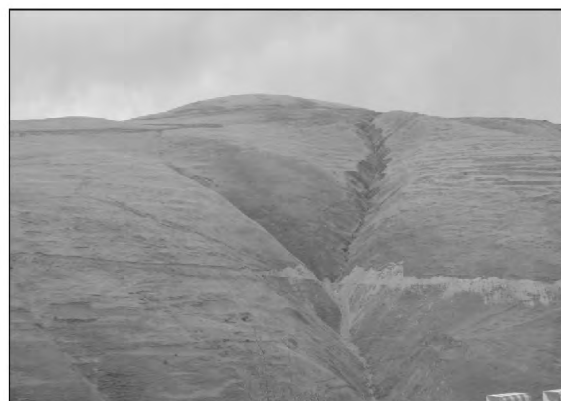
d 冻融引起的沟壁沿临空面垮塌
