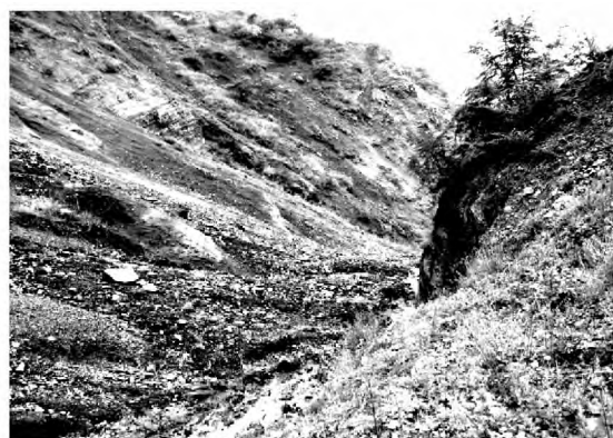
a 左岸滑坡半堵塞沟道
