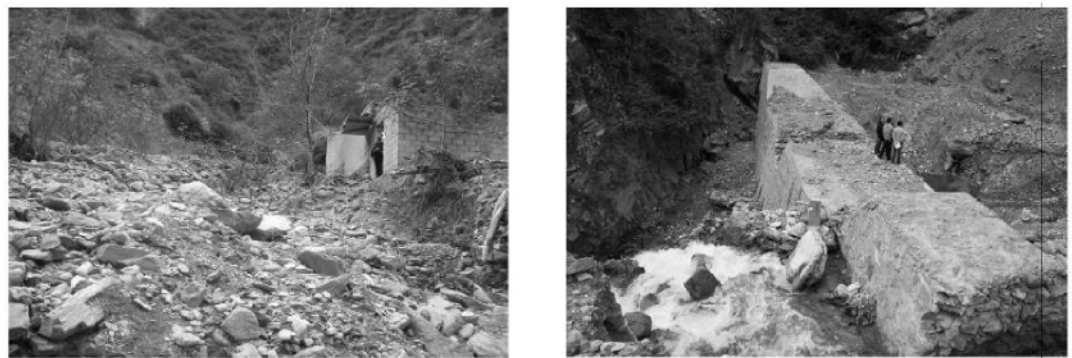
图 4 支沟蚂蝗沟沟口和 B 处拦砂坝
