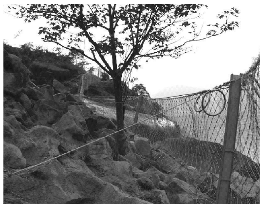
图 2 缙云至青田某段危岩拦石网工程
